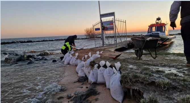
Woensdagavond 10 januari 2024: Provisorische herstelwerkzaamheden en zandzakken om de steiger te beschermen tegen de golven en het hoge water.
