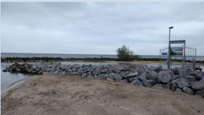
23 april 2024: Een door het Hoogheemraadschap herstellende en sterk verbeterde waterkering welke beter bestand is tegen toekomstige hoogwaterpieken.
